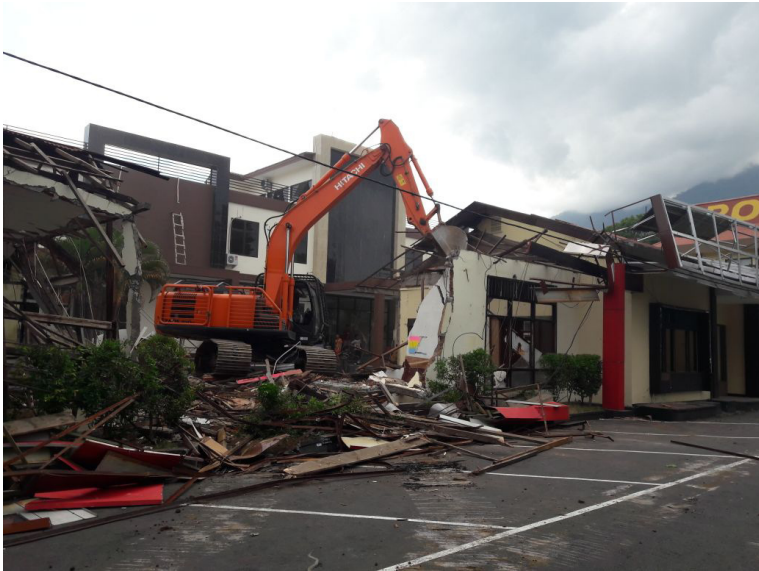
Achmat Juri menelorkan ide untuk membuat kantor Polda Malut berkelas dan tidak sumpek melainkan nyaman sebagai tempat kerja bagi seluruh jajarannya. Foto: saat proses pembangunan Mapolda Malut
