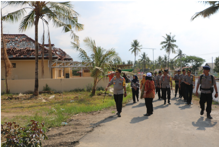
Seluruh fasilitas gedung Polres Lotara lumpuh total akibat gempa. Kapolda NTB meninjau fasilitas Polres Lotara yang rusak nyaris seluruhnya
